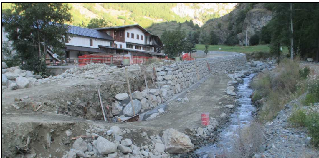
Arginatura in corso d'opera
